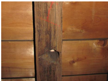
Afbeelding 5: Nog een foto die genomen is in de kerkkap van de kerk te Hei- en Boeicop. Hierop is de onderzijde van het dakbeschoot en een dakspoor te zien. Ook hier is een houtvlotverbinding zichtbaar met driehoekig afgeschuinde randen.
