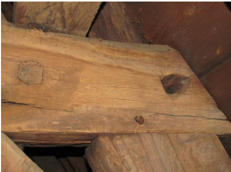
Afbeelding 3: Deze foto is genomen in de kerkkap van de kerk te Hei- en Boecop. De linkse houtvlotverbinding is in afbeelding 4 sterk uitvergroot. Bij de rechtse houtvlotverbinding is rondom het gat een driehoekige uitsparing gemaakt. Die diende om het afschuren van de touwen tegen de scherpe hoeken van de balken te voorkomen.
