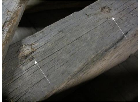
Afbeelding 2: Op deze foto zijn twee houtvlotverbindingen zichtbaar. In de gaten zijn de restanten van twijgen aanwezig die met een houten klosje zijn vastgeslagen.
