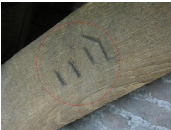
Afbeelding 5: Dit telmerk is in het verhaal genoemd. Het is een gehakt telmerk in de kap van het schip en vormt het telmerk III> (4). Ook weer een zogenaamd gebroken telmerk om onderscheid te maken tussen rechts en links.
