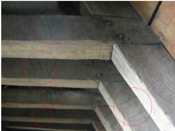
Afbeelding 3: Op deze foto, genomen in een van de transepten, zijn sporen (de schuine balken) en hanebalken (de horizontale balken) zichtbaar waarin gesneden telmerken zijn aangebracht. In oplopende volgorde zijn de telmerken IV (6), IIV (7), IIIV (8) en IIIIV (9) te zien.
