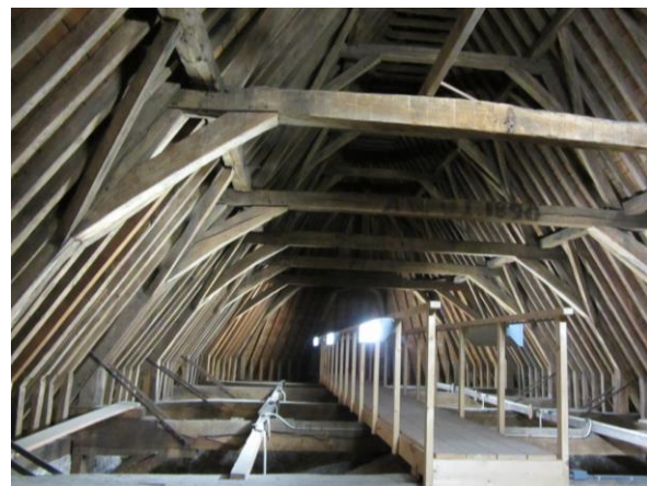
Afbeelding 6: Een overzichtsfoto van de kap boven het koor. Wanneer zo'n kap met zoveel verschillende onderdelen elders in een werkplaats werd gemaakt, dan kun u zich wel voorstellen dat een telsysteem van essentieel belang is.
