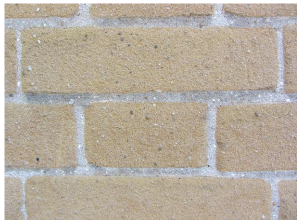
Afbeelding 4: Detailfoto van de lichtgele kalkzandsteen in een van de woningen aan de Siemensstraat, de witte niet vermalen kalkpitten zijn duidelijk zichtbaar.
