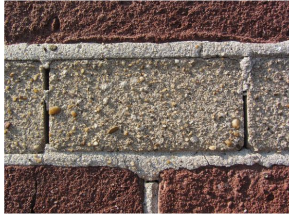
Afbeelding 8: Detailfoto van de toegepaste kalkzandsteen in het stationsgebouw, de kalkzandstenen bestaan uit grove bestanddelen (kenmerkend voor de eerste generatie kalkzandsteen). Ook zijn de witte, niet vermalen kalkpitten duidelijk zichtbaar.
