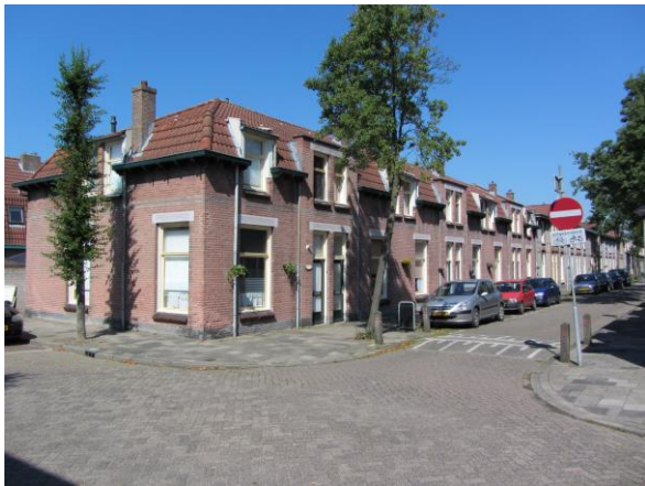
Afbeelding 1: Fragment van de Siemensstraat, zwarte kalkzandsteen voor de plint en gevelbanden en rozerood (appelbloesem) voor de gevels.
