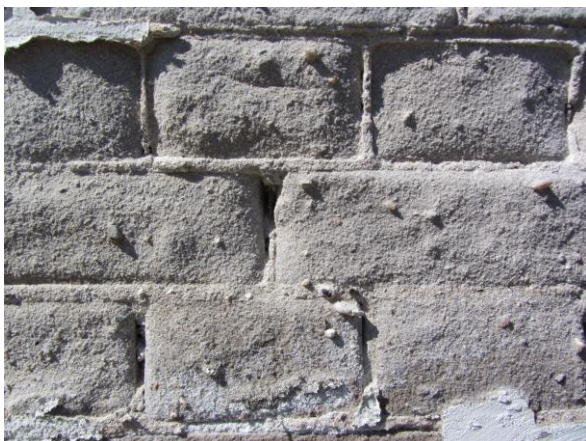
Afbeelding 3: Detailfoto van de kalkzandsteen in de voorgevel van een van de woningen aan de De Ruijterstraat, de stenen zijn behoorlijk verweerd, de harde niet vermalen stukjes in de samenstelling van de grondstof zijn duidelijk zichtbaar.
