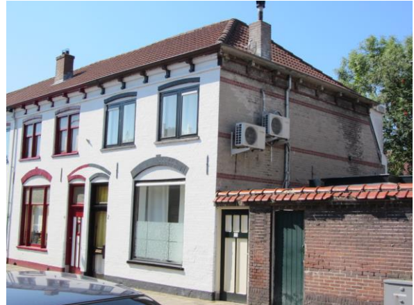
Afbeelding 6: Foto van de kopgevel van de De Ruijterstraat nr. 2, waarop de ongeschilde kalkzandsteen goed zichtbaar zijn.
