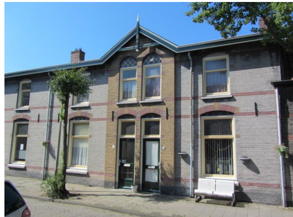
Afbeelding 2: Fragment van de Siemensstraat (nr. 24 en 26), zwarte kalkzandsteen voor de plint, grijze voor de gevels, rozerood voor de gevelbanden en bogen boven de gevelopeningen, lichtgele voor het risalerende topgeveltje en grijs en zwart voor de boogvullingen boven in het topgeveltje.
