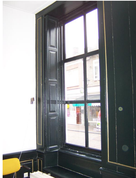
Afbeelding 3: binnenluiken, de vierdeling correspondeert niet met de huidige vensterindeling
